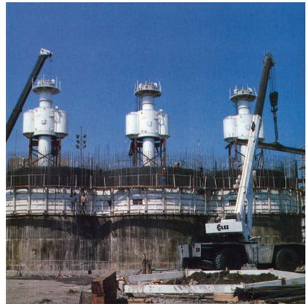
Figure 1 : Mise en place de caissons - Tubes et sas pour air comprimé
